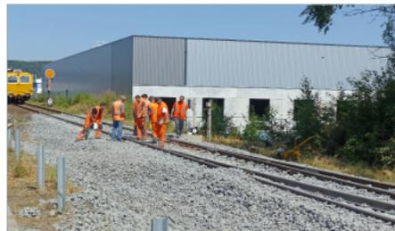
Neue Schwellen und Schienen sind bereits gelegt, die Weiche funktioniert schon, aber die Gleise müssen noch eingeschottert werden.
