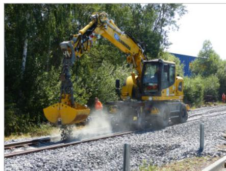
Ein auf den Schienen fahrender Bagger füllt den Schotter zwischen Schienen und Schwellen.
