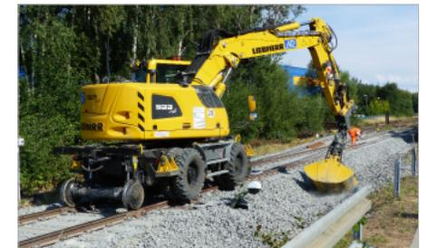
Verschweißt werden die Schienen in der Nacht, tagsüber haben sich die Schienen bei diesem Wetter zu sehr ausgedehnt.
