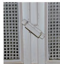
Viel sicherer sind einfache Riegel. Sie lassen sich von außen nicht öffnen. Solche Riegel nutzt man an Kellerfenstern, die man sowieso nur von innen schließt und öffnet.
