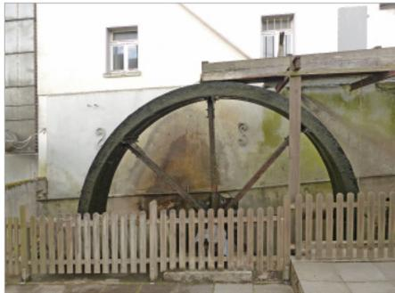
Die Schaufeln des Mühlrades werden mit Wasser gefüllt, das Gewicht des Wassers drückt sie nach unten. Die Kraft, die das Mühlrad in die Mühle übertragen kann ist abhängig von der Größe der Schaufeln und der Menge des zufließenden Wassers.
