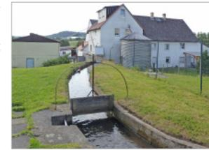
Der Mühlgraben gewährleistet einen stetigen Wasserfluss, denn durch Wehre schon am Abzweig aus dem Bach und vor dem Mühlrad kann die Menge des Wassers reguliert werden, das auf das Mühlrad läuft.
