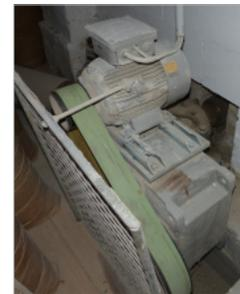
Die Transplantation an der Spitzmühle erfolgte innen direkt an der Achse des Mühlrades. Da ist ein Getriebe angeschlossen, das die Drehbewegung über einen Riemen auf einen Generator überträgt.
