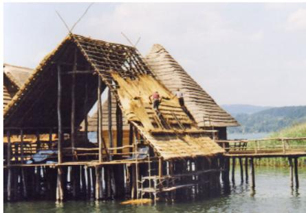
Baumstämme bilden das tragende Gerüst. Das Prinzip nach den Gesetzen der Statik ist bei unseren Fachwerkhäusern heute noch gleich.
