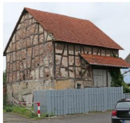
Welcher Balken trägt welches Gewicht wie und wohin ab. Schräg eingebaute Balken versteifen die Konstruktion, damit sie sich nicht nach der Seite neigt.
