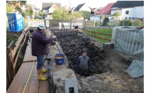
Damit Wasser abgeführt werden kann, das von oben durch das Pflaster eindringt, ist auf beiden Seiten am Fuße des Bauwerks jeweils eine Drainage angelgt.
