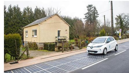
Die Module haben eine Lebensdauer von etwa 20 - 25 Jahren. Sie können dann einfach abgefräst und zu 95 % recycelt werden. Die Kosten liegen jetzt noch bei 250 € pro Quadratmeter.
