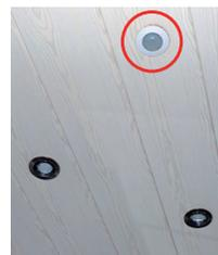
Deckenstrahler wie hier im Bad lassen sich ganz einfach umrüsten. Ein Strahler wird durch einen Bewegungsmelder ersetzt. In die beiden anderen Strahler steckte ich etwas stärkere Leuchtmittel ein.
